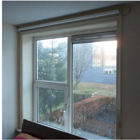
Overall dubbel glas en ventilatieroosters
