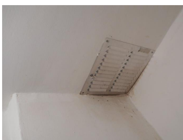
Natuurlijke ventilatie onvoldoende
