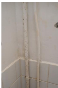
op veel plekken ontstaat voortdurend schimmel
