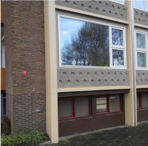
Spouwmuren vullen, borstwerping isoleren
